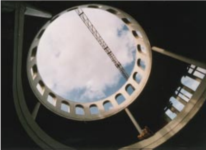
Das Foto entstand während der Bauarbeiten an der ATIB-Moschee.
